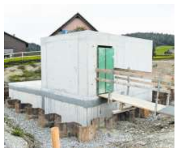
Der Rohbau des neuen Pumpwerks in Guntershausen. Bild: kli
